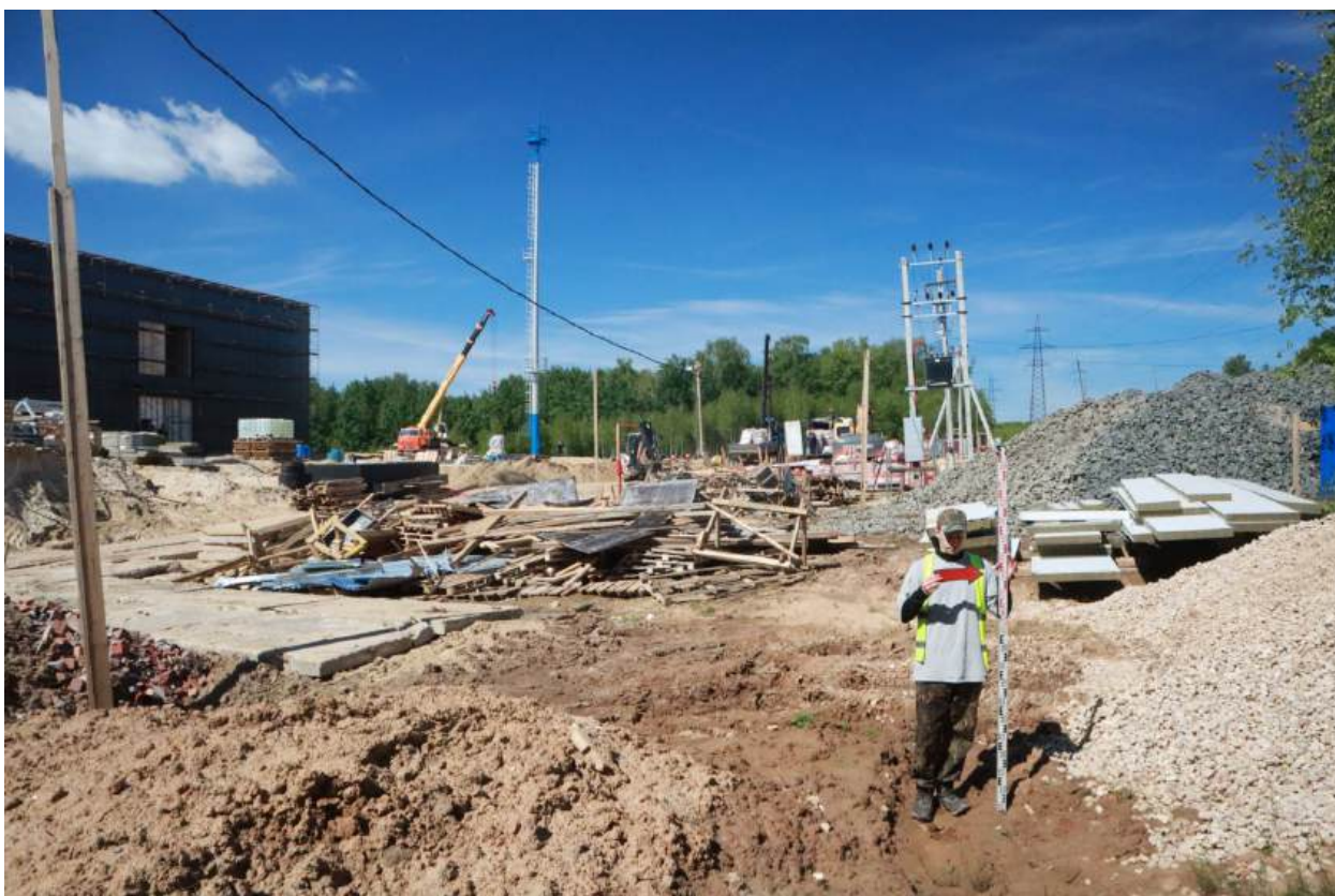
Рис. 22. Обеспечение сохранности ОКН федерального значения «Поселение Ольгинское» в г. Нижний Новгород. 2026 г. Участок проектирования. Точка фотофиксации 1. Вид с В.
